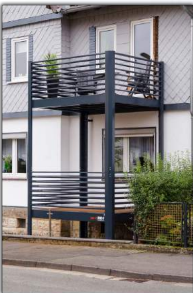
2-fach Balkon mit anthrazitgrauer Pulverbeschichtung (RAL 7016), Lamellengeländer und ThermoKiefer Bodenbelag
