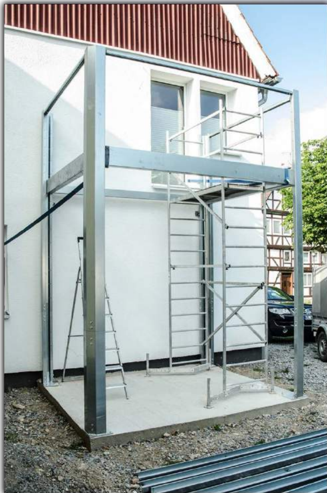
Balkon beim Aufbau Es wird kein Kran benötigt
