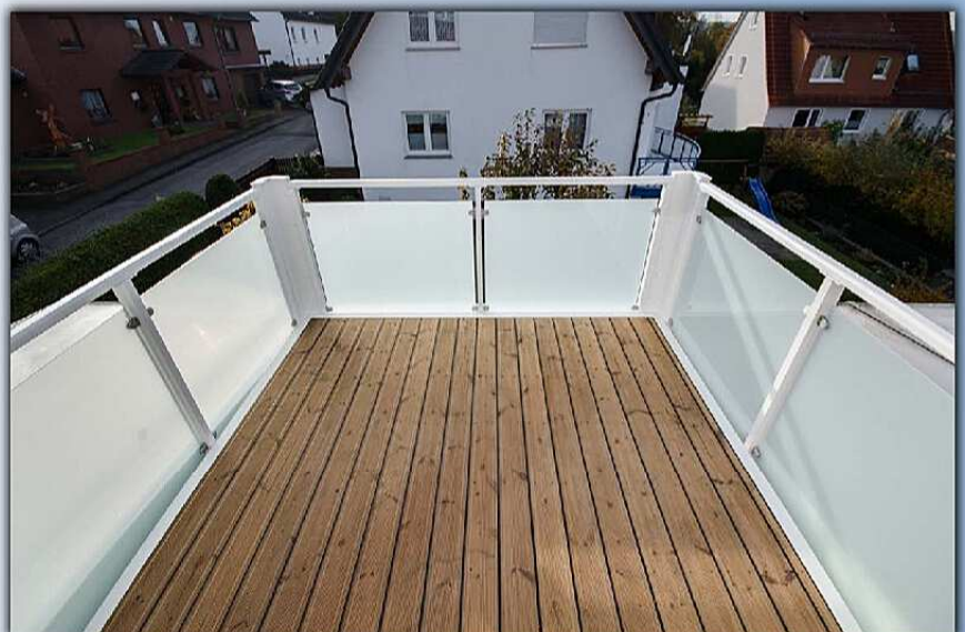
Balkon mit verkehrsweißer Pulverbeschichtung (RAL 9016), Glasgeländer und ThermoKiefer Bodenbelag
