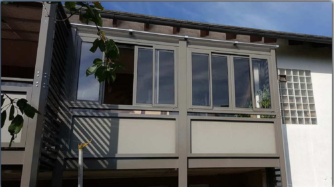
Balkon mit quarzgrauer Pulverbeschichtung (RAL 7039), Überdachung und Fenster
