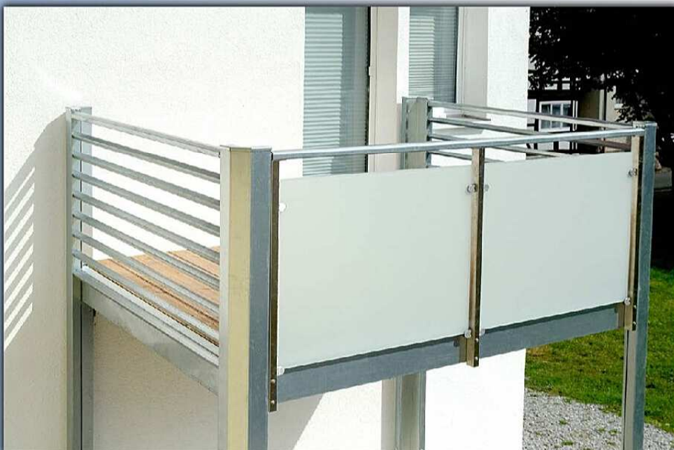
Verzinkter Balkon mit Lamellengeländer (seitlich) und Glasgeländer Satinato (vorne)
